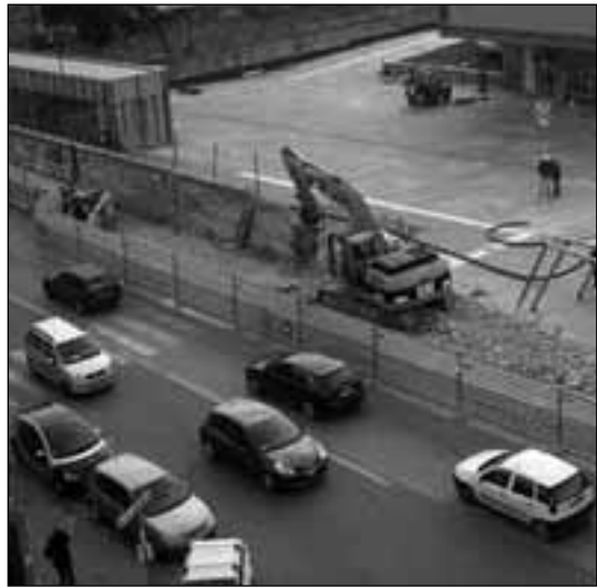
Il muro di Bagnoli durante l'abbattimento
